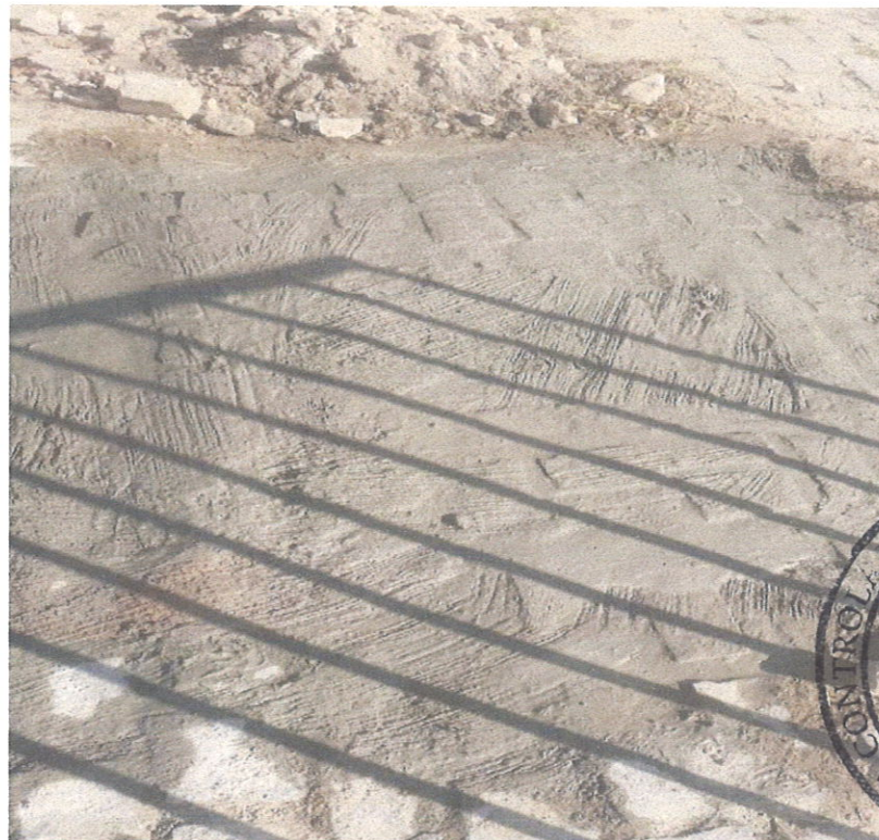
Foto 04- Reassentamento de paralelepípedo, rejuntamento com argamassa.
