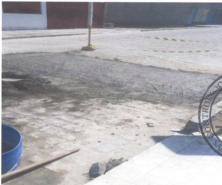
Foto 06- Reassentamento de paralelepípedo, rejuntamento com argamassa.
