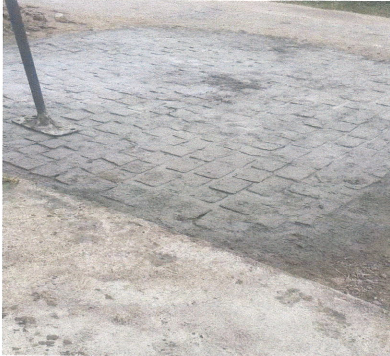
Foto 07- Reassentamento de paralelepípedo, rejuntamento com argamassa.
