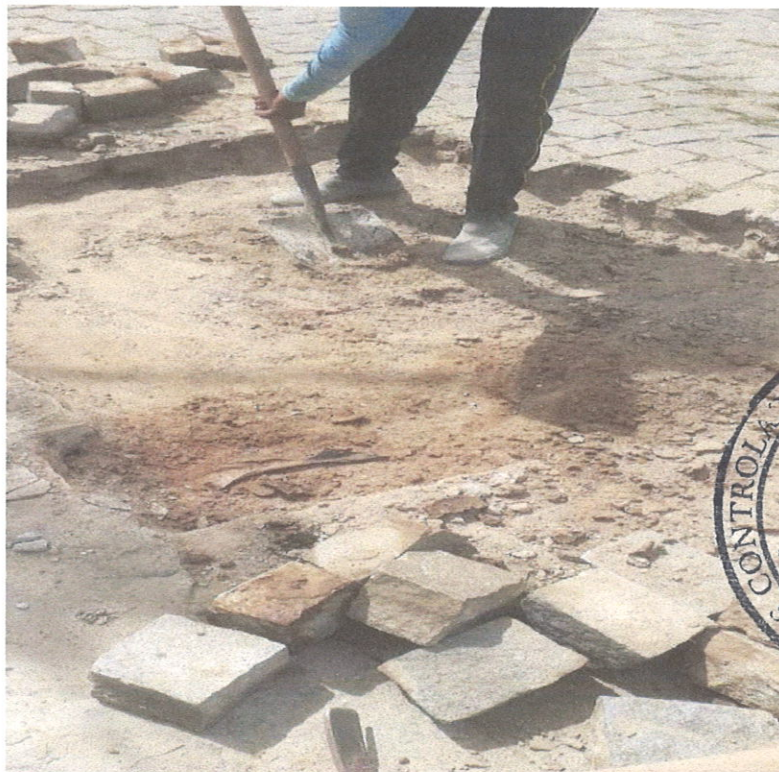
Foto 08- Reassentamento de paralelepípedo, rejuntamento com argamassa/ Aterro com pó de brita – areia
