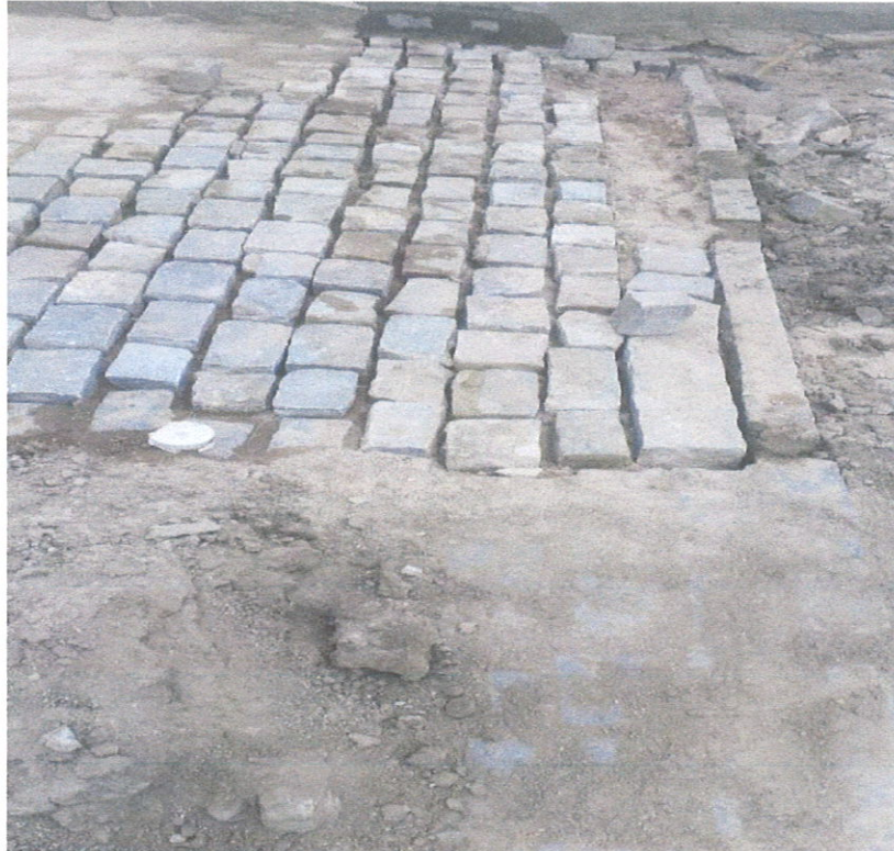
Foto 03- Reassentamento de paralelepípedo
