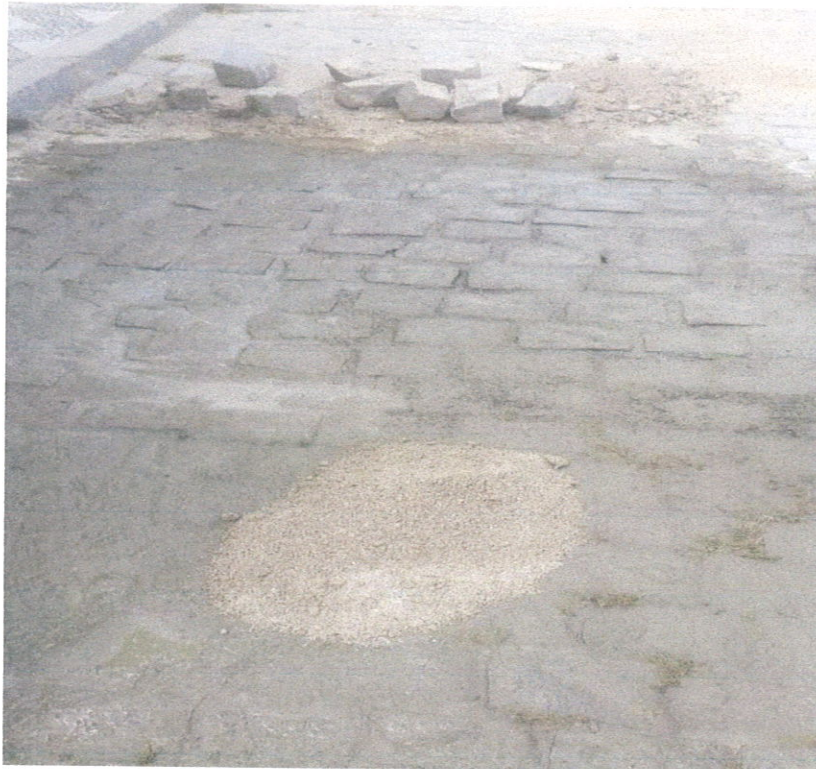
Foto 11- Remoção e reposição de meio-fio
