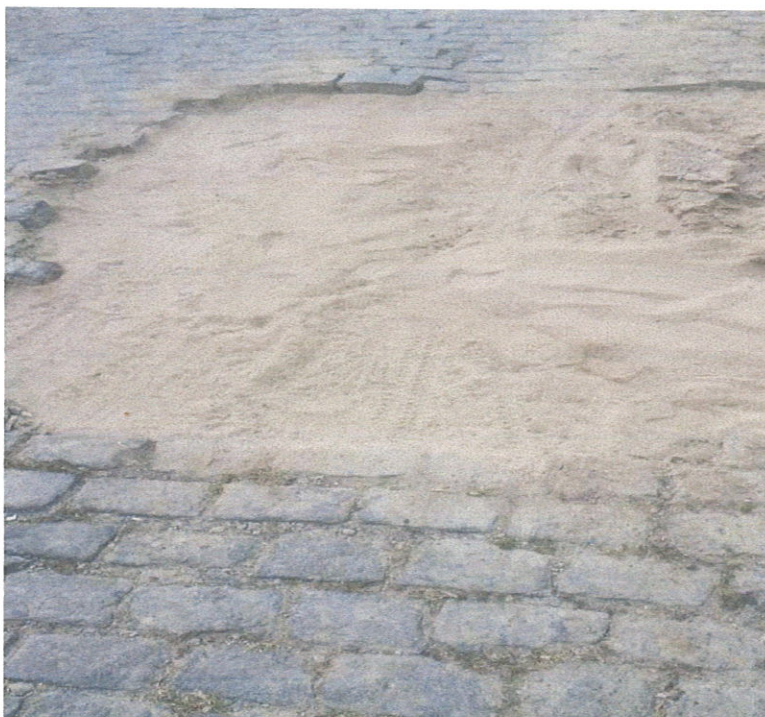
Foto 09- Reassentamento de paralelepípedo, rejuntamento com argamassa/ Aterro com pó de brita – areia
