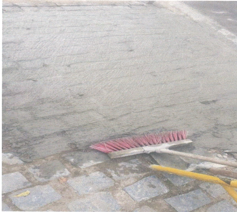
Foto 05- Reassentamento de paralelepípedo, rejuntamento com argamassa.
