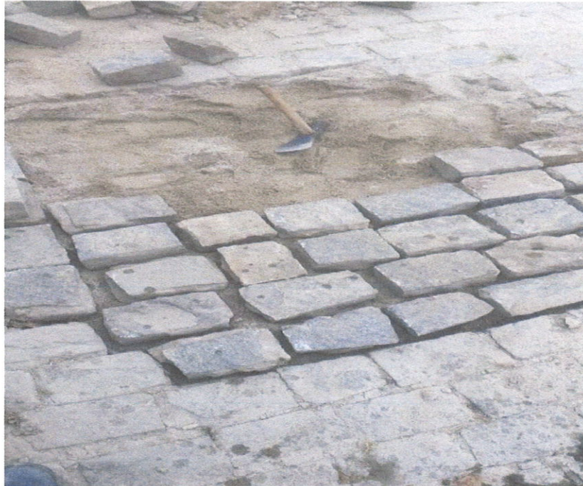
Foto 01- Reassentamento de paralelepípedo
