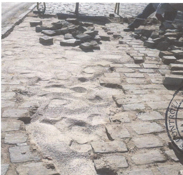
Foto 10- Reassentamento de paralelepípedo, rejuntamento com argamassa/ Aterro com pó de brita – areia
