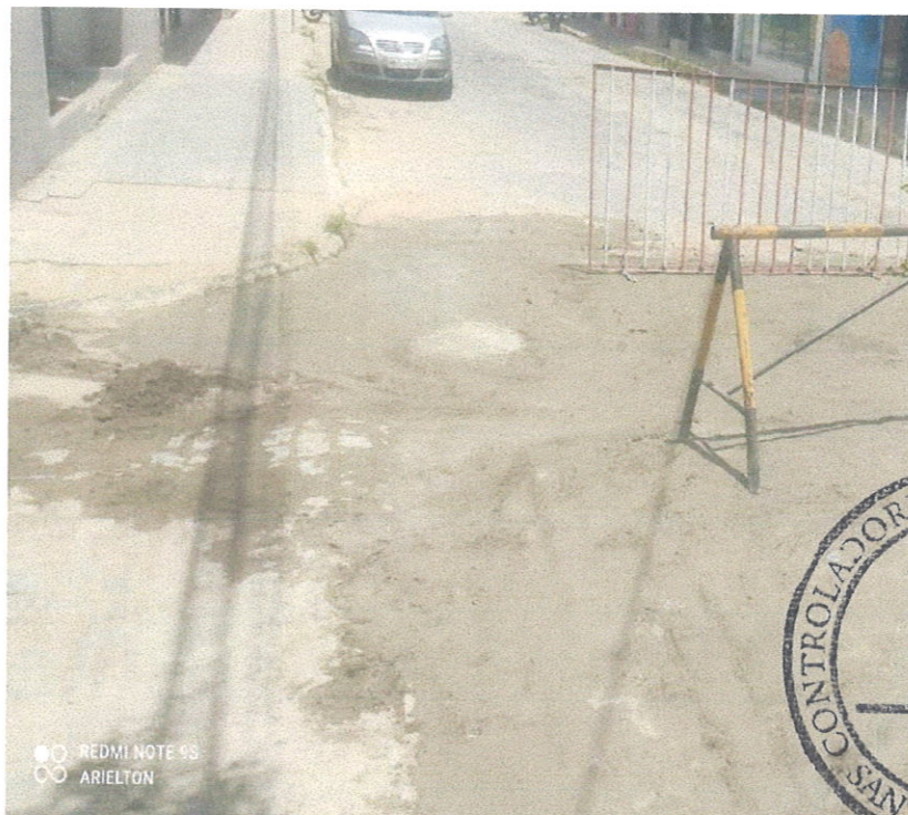
Foto 12- Remoção e reposição de meio-fio
