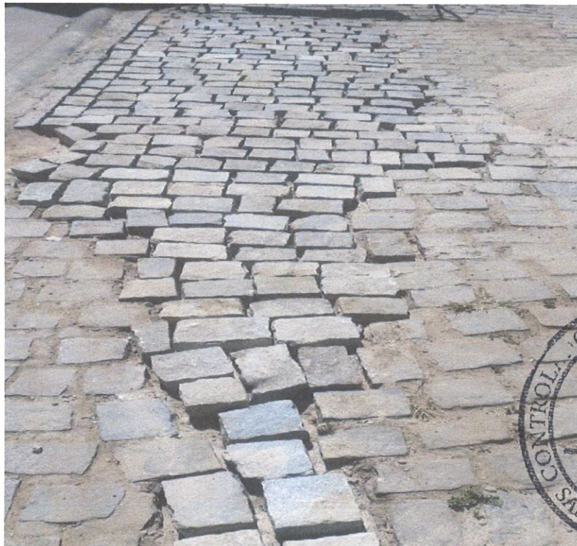
Foto 02- Reassentamento de paralelepípedo
